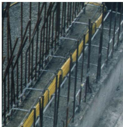
вспомогательные элементы из арматуры для крепления гидрошпонок
